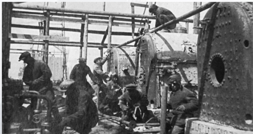
Монтаж оборудования на Сызранском нефтеперерабатывающем заводе
