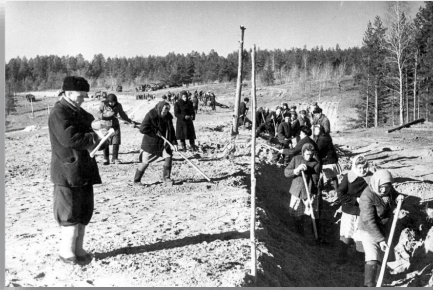
Колхозники на строительстве Волжской рокады. Сызранский район. 1942 год
